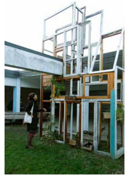
Bau einer Pergola aus recycelten Fenstern
