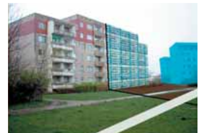
Mögliche Strategien zum Umgang mit Gebäuden an Feldübergängen: erhalten, abreißen, einpacken
